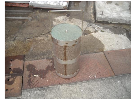
本体及び部品洗浄 新フィルター設置
