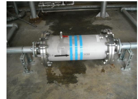
エアー抜き作業後完了
