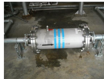
エアー抜き作業後完了
